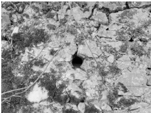
Slika 10. Rupa za odvod vode na pročelju bedema pregrađa
